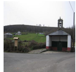
Capilla de los Remedios
