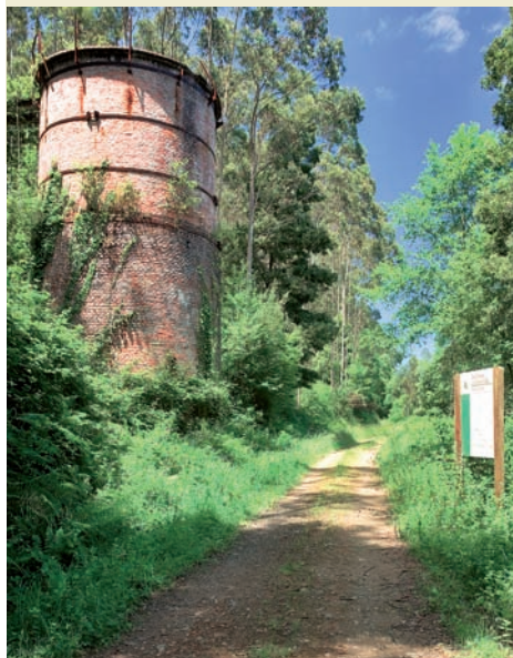
horno de la Mina
